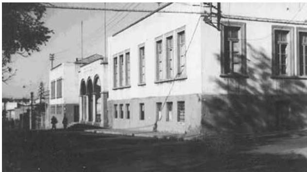
Asmara. L'edificio del Liceo-Ginnasio "Ferdinando Martini". Asmara. The building of Liceo-Ginnasio (High School) "Ferdinando Martini."
